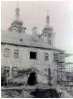
Aufnahme der beschädigten Kirche in Hajnice (Haindorf).
