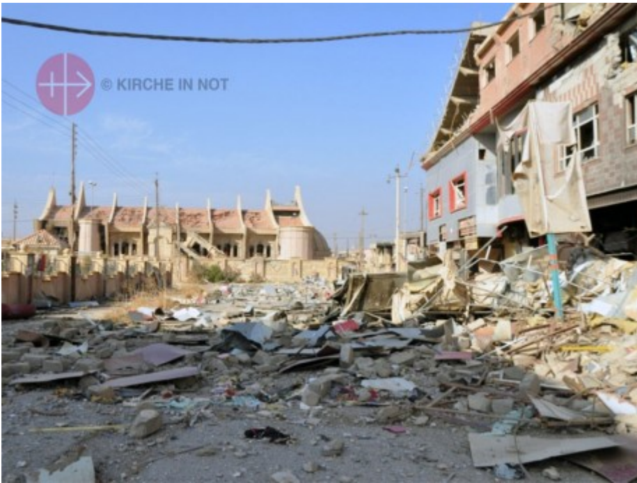
Zerstörte Häuser in Karakosch.
